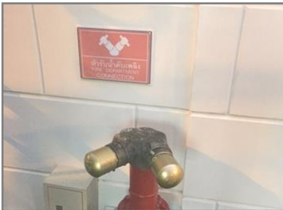
ป้าย หัวรับน้ำดับเพลิง
